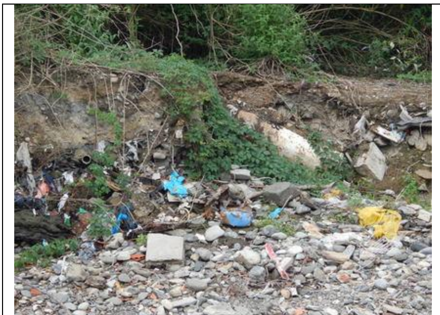
Ancienne décharge d'Agos-Vidalos après la crue de juin 2013, source : C-PRIM
