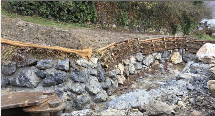
Travaux de réouverture du Souët à Gaillagos
