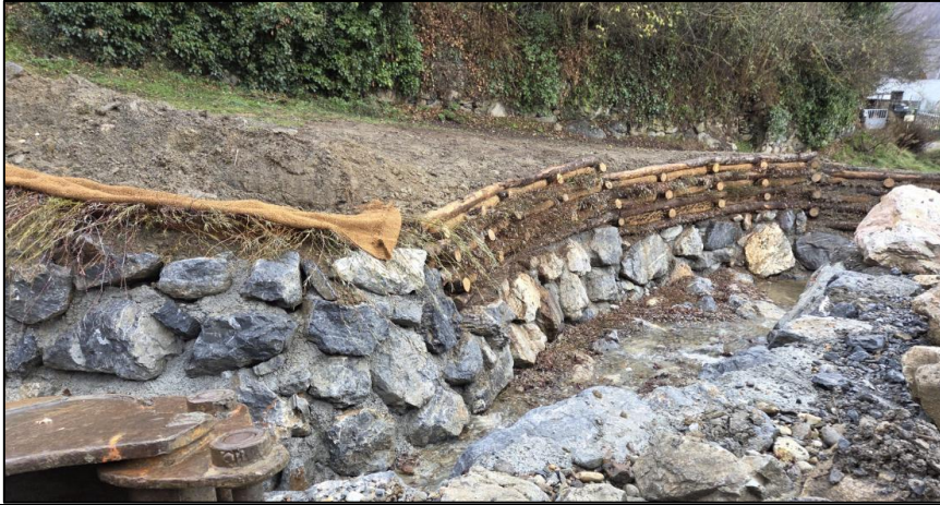
Travaux de réouverture du Souët à Gaillagos
