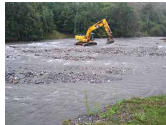
📷 Epi déflecteur édifié en urgence pour réduire inondation le 08/09/2024
