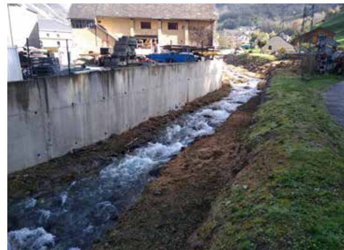
📷 Après intervention sur l'Yse à Luz-Saint-Sauveur
