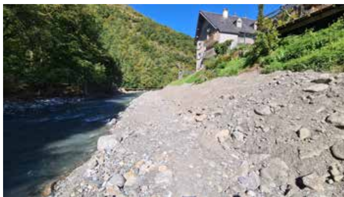
📷 Secteur confluence – post-crue 2024 après travaux d'urgence
