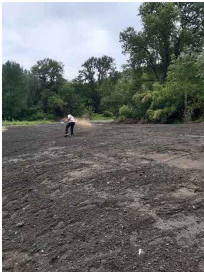
📷 Renaturation des zones de chantier par semis d'espèces locales - GER
