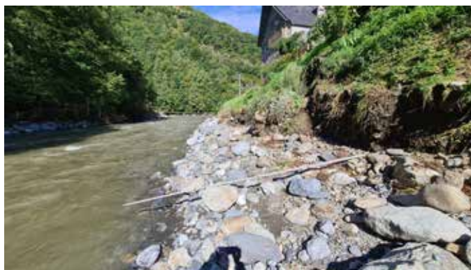
📷 Secteur confluence – post-crue 2024 avant travaux
