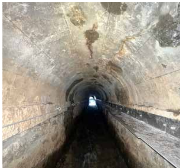
Ouvrage SNCF avec installation d'une banquette aluminium
