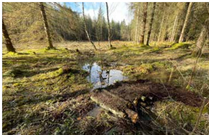
📷 Installation de piézomètre pour suivre l'évolution de la zone humide
