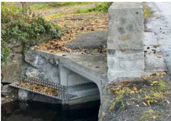
📷 Accompagnement de la commune de Lau-Balagnas pour restauration d'un passage pour la faune et les hautes eaux
