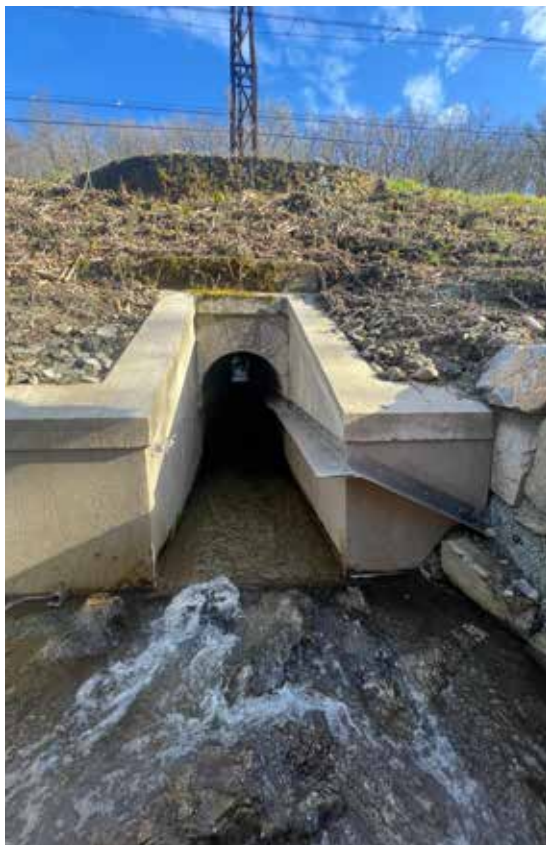
Ouvrage SNCF avec installation d'une banquette aluminium
