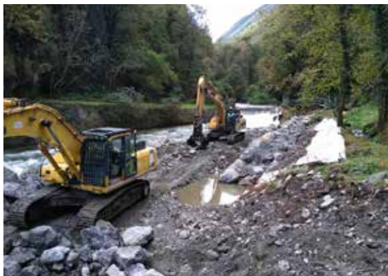
📷 Confortement du système d'endiguement à Pierrefitte-Nestalas Soulom
