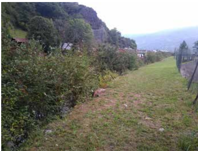
📷 Avant intervention système endiguement gave Cauterets
