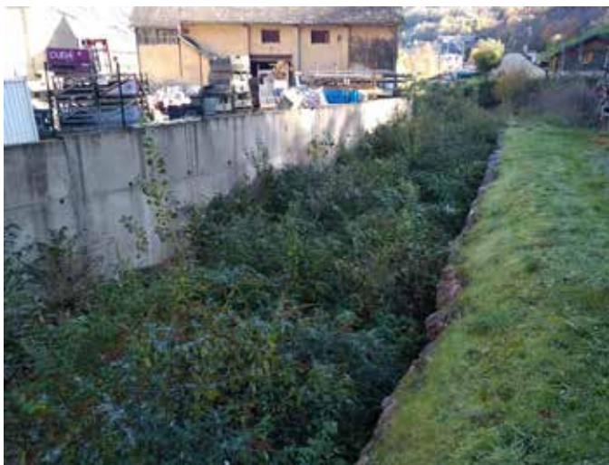
📷 Avant intervention sur l'Yse à Luz-Saint-Sauveur
