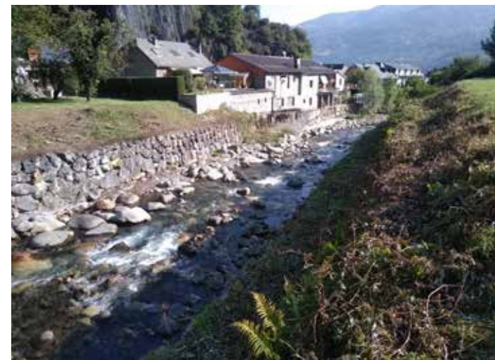
📷 Après intervention système endiguement gave Cauterets
