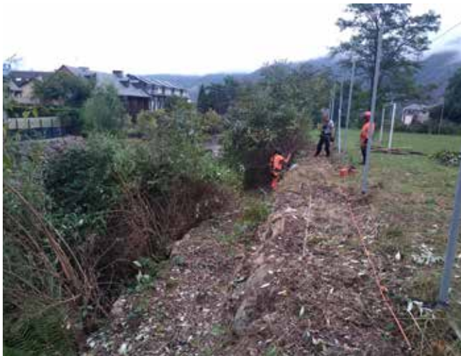
📷 Intervention avec une entreprise spécialisée dans les travaux en hauteur
