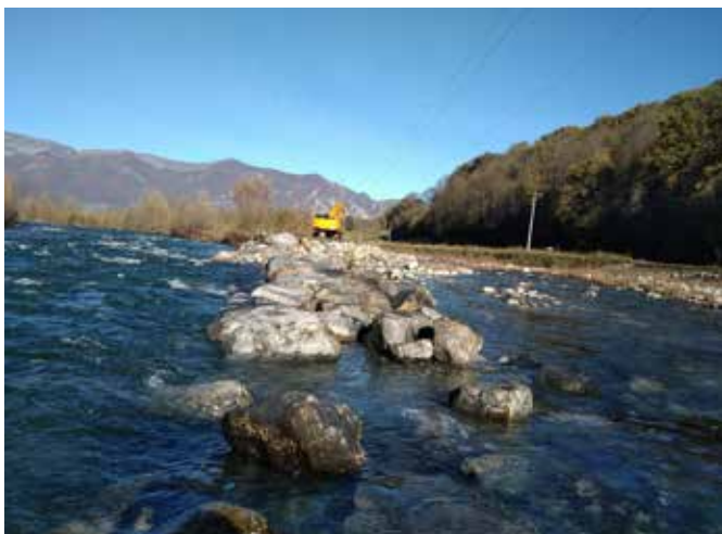
📷 Après les travaux de reprise de la barrette
