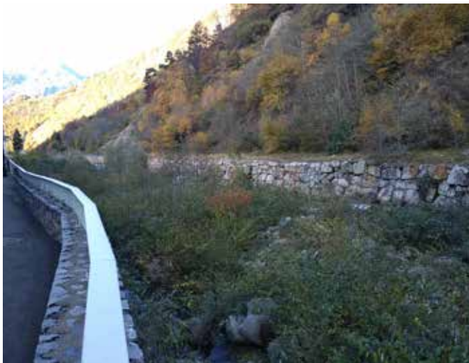
📷 Avant intervention sur le Bastan à Barèges
