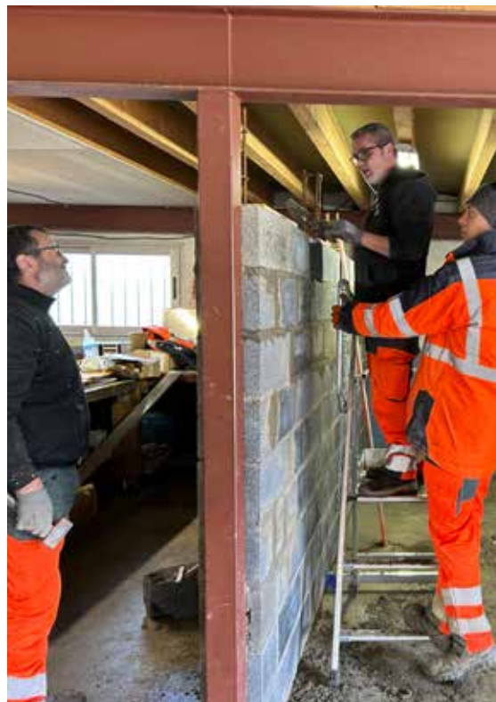
📷 Travaux de maçonnerie réalisés par l'ACI
