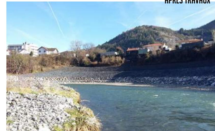
Fin décembre 2017, les travaux d'enrochement sont terminés et les remblais sont quasiment finis.
