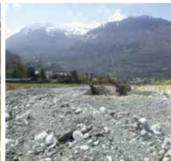
📷 Travaux de purge des plages de dépôt du Bastan à Luz
