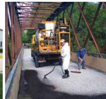
📷 Amélioration du revêtement du pont de fer sur la Voie Verte
