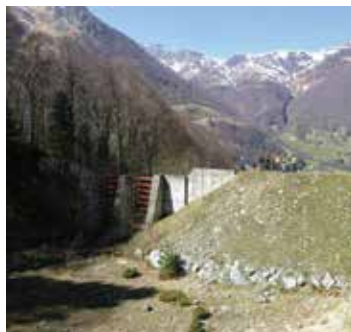
📷 Visite de l'ouvrage communal de la plage de dépôt de la Gorce à Cauterets
