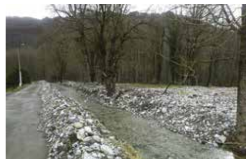
VUE DE LA PLAGE DE DÉPÔT DE L'AMONT VERS L'AVANT APRÈS L'INTERVENTION COMMUNE/PLVG
