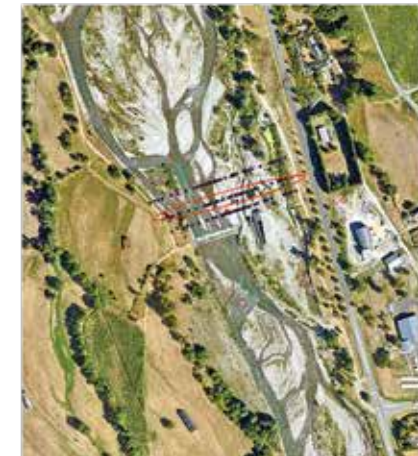
Levé de profils en travers
