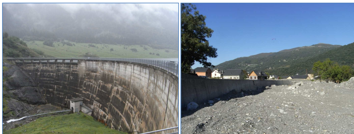
Photo 15 : Barrage du Tech géré par EDF sur le gave d'Azun (gauche) et digue de protection de Pierrefitte-Nestalas (droite)
