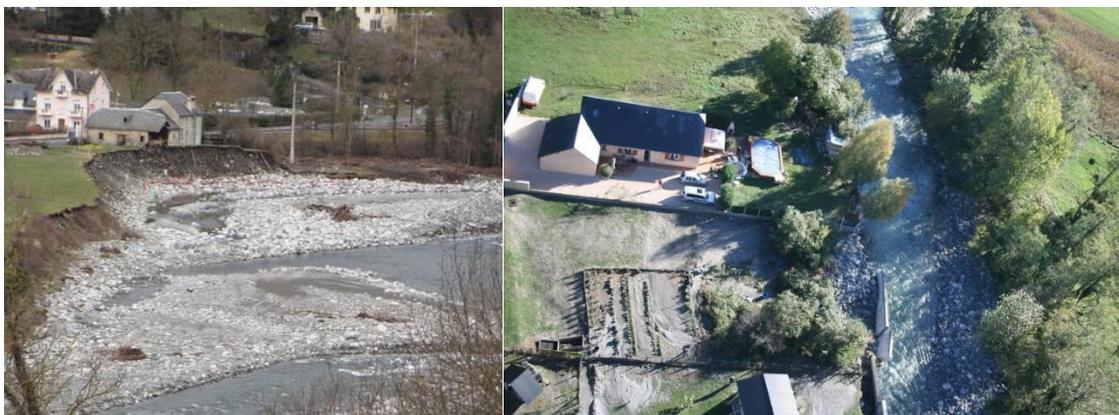
Figure 20 : Effets de la crue d’octobre 2012 sur l’espace de mobilité du grave de Gavarnie sur la commune de Saligos (à gauche) et sur l’ouvrage de protection contre les crues du gave de Cauterets à Pierrefitte-Nestalas (à droite), source : C-PRIM
