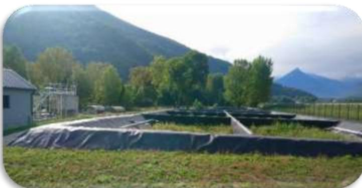
*Nouvelle STEP avec traitement des boues par lits plantés de roseaux, construite pour remplacer l'ancienne devenue obsolète – Agos-Vidalos*
