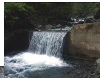
Photo 4 : seuil sur la Pique (31) sans passage au travers ni voie de contournement © F. Blanc
