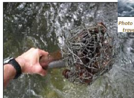
Photo 2 : Tuyau équipé d'un dispositif de protection artisanal et vulnérant © F. Blanc
