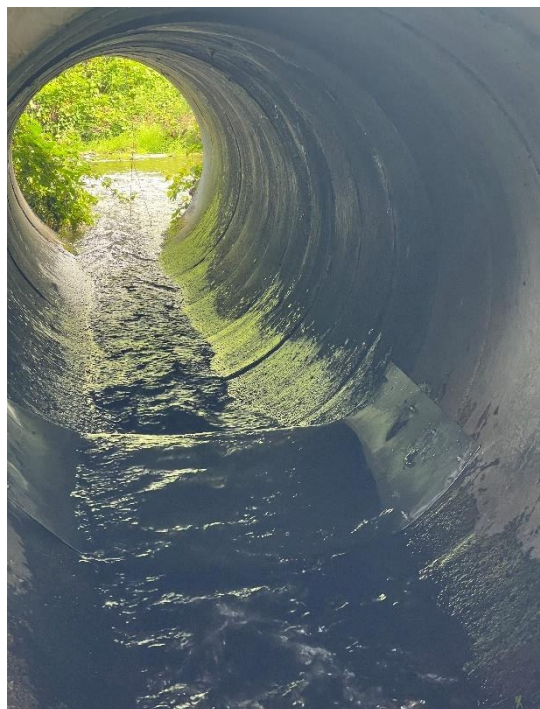
Figure 30 : Dispositif anti-remontée d'écrevisses du Saint-Pastous © C. Chiray
