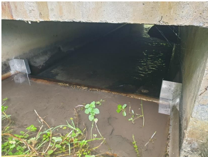
Figure 29 : Dispositif anti-remontée d'écrevisses du Bayet © R. Duguet
