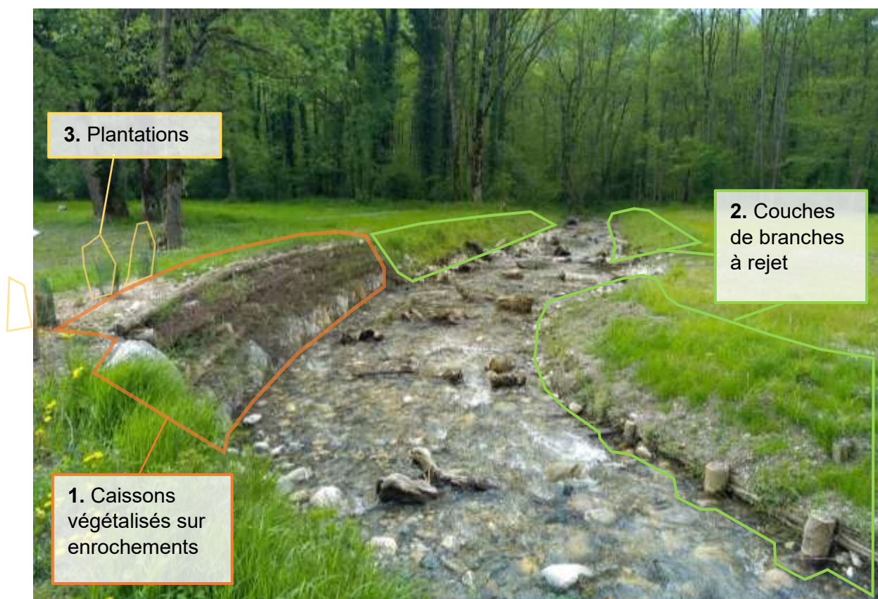
Figure 4 – Localisation et état des aménagements à l'aval du pont de Cradey au 23/05/2024 (photo : PLVG)
