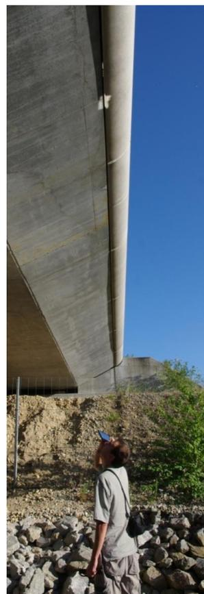
Photo 10 : Inspection des corniches d'un pont TGV
