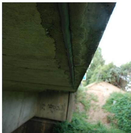
photo 19 : Cavité bouchée à l'aide de gaine d'isolation de tuyaux de chauffage © Sophie BAREILLE
