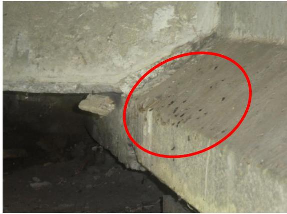
Espaces entre-poutres sous le tablier -- exemple d'une zone utilisée par les chauves-souris, avec guano sur le rebord
