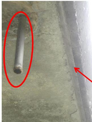
Drain très probablement inutilisable par les chauves-souris (car fonctionnel et dépassant largement de la maçonnerie) et corniche amont bétonnée
